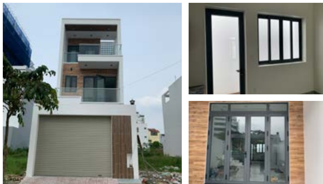
Công trình nhà phố - Công ty XD Giang Thành Nam - Quận 12 House project - Giang Thanh Nam Construction Company - District 12
